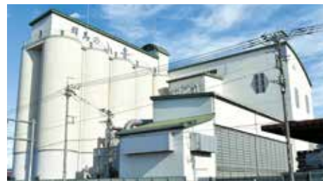
▲カントリーエレベーター
